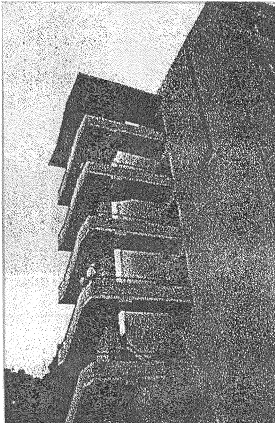
Foto 23. Vista de bloque de escaleras de emergencia (Hosp. Rodríguez Zambrano)
