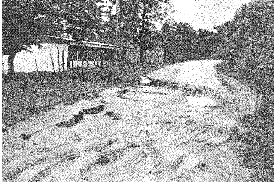
Foto 37 Licuación de arenas en Tahuishco (Moyobamba)
