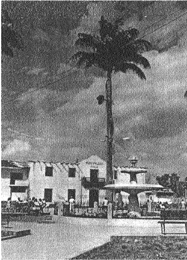
Foto 17 Ciudad de Rioja. Plaza principal-Municipalidad en demolición.
