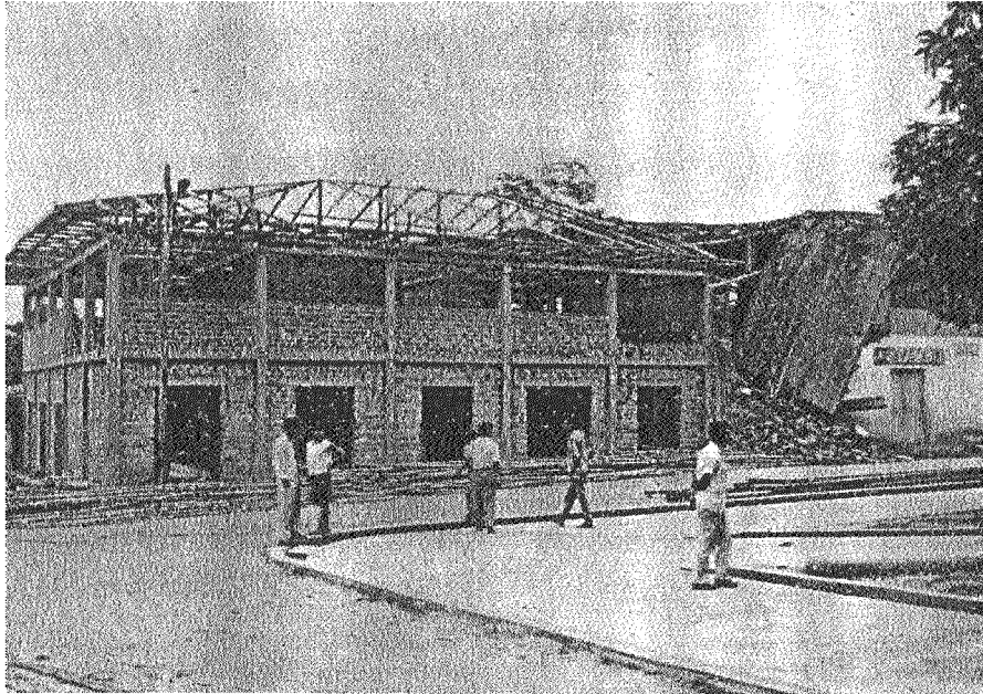
Foto 12 Vivienda de concreto armado en construcción (Soritor)
