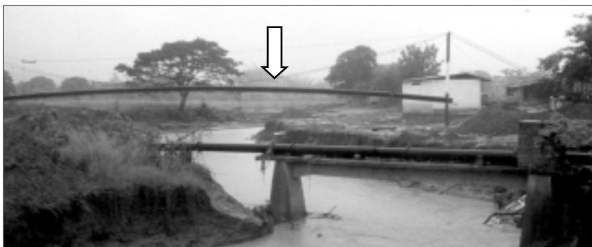
Medida de mitigación, paso elevado de mayor seguridad. Fenómeno El Niño, Ecuador 1998
